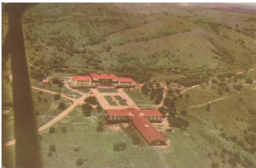
Vista aérea del parque de vacaciones, s.d., con sus edificios originales 3
